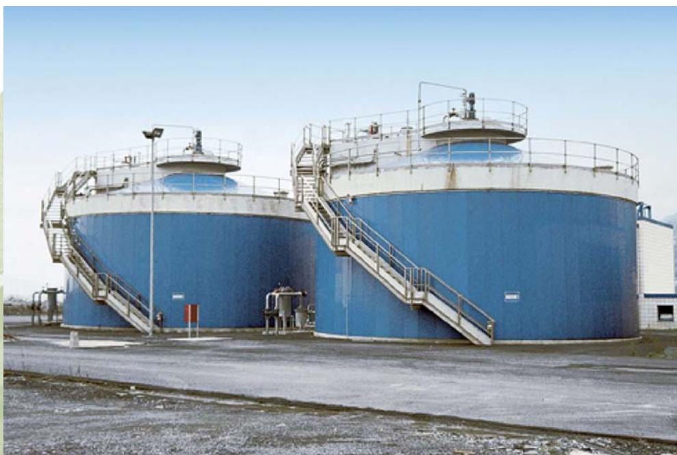
Fig. 8.1. Exemplo de dous dixestores anaerobios
